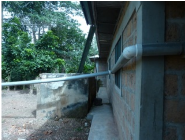
Rohrleitungen Wassersystem
