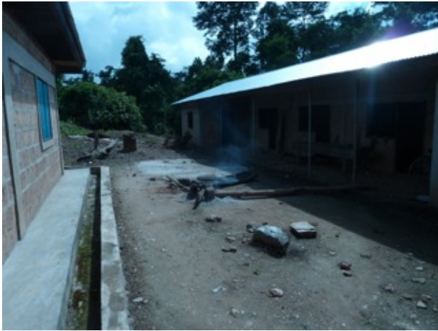
Neuer Anbau, provisorische Feuerstelle
